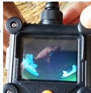
Biofilms à l'intérieur des tuyauteries
